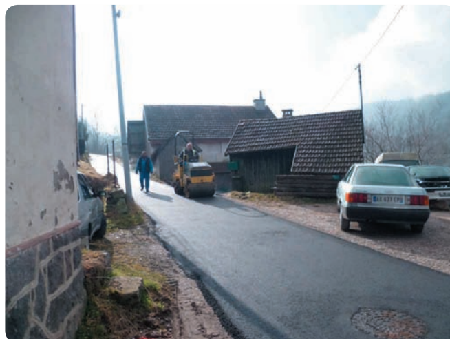
Pose de l'enrobé sur le chemin de Varcivaux.
